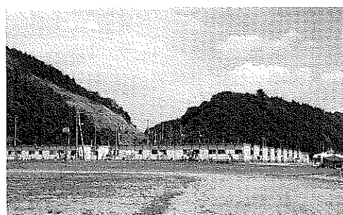
9月中旬、石巻市川前グランド 仮設住宅遠景
